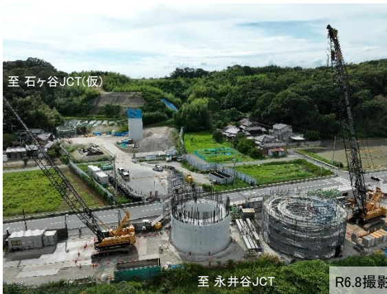
石ヶ谷JCT(仮)付近(明石市)
