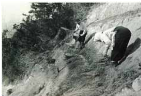
水平階段を切り、苗木植栽のための鉢床をつくるため土を芝で固める
