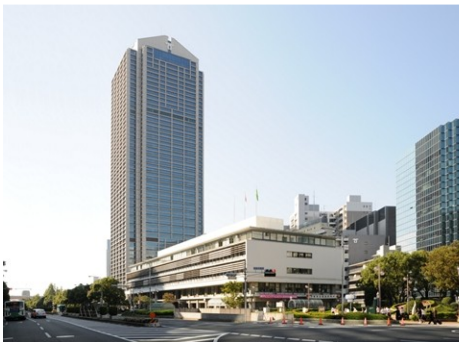
神戸市役所（本庁舎1号館・2号館）
