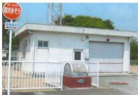
写真2-18 消防団が管理している消防団倉庫
