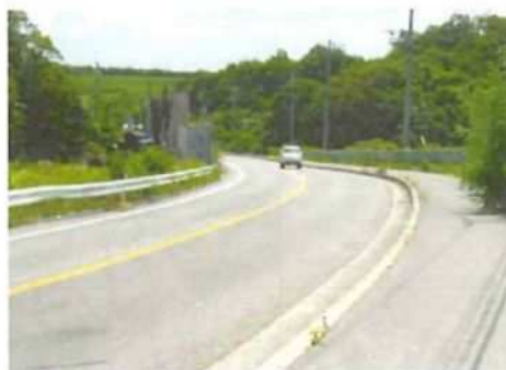
写真 3-5 市道神戸・二見線の様子
