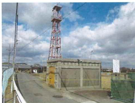
写真7 半鐘と旧ポンプ庫
