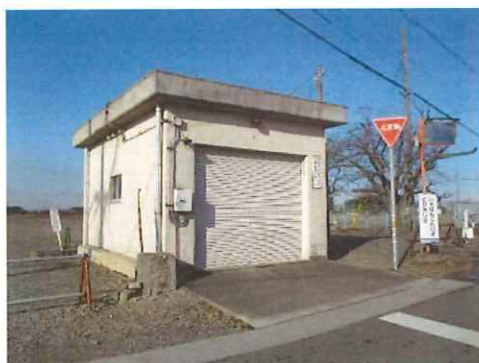
写真5 消防ポンプ庫
