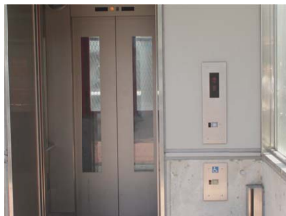
写真3-3-3 乗降口の操作盤設置例
