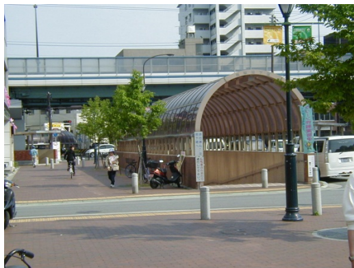
写真3-4-1 傾斜路の設置事例（兵庫駅南出口付近）
