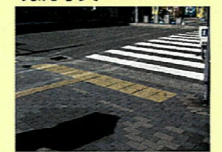
経路 1-3 八幡線 現況写真
