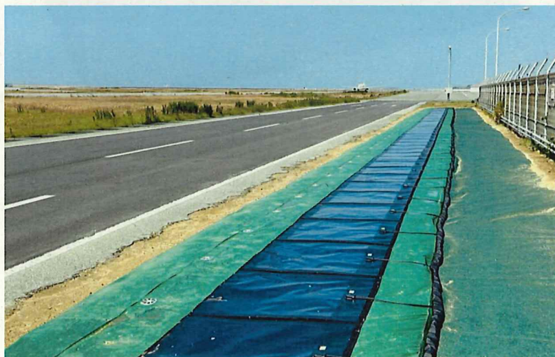
ペロブスカイト太陽電池の設置状況
