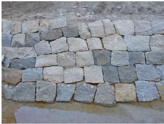
第1期防波堤 北東部南面（西半） （南から）
