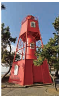
fig14：旧和田岬灯台の 現況写真
