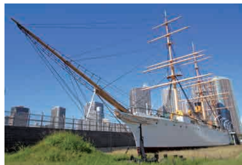
fig13：明治丸全景（東京海洋大学内）
