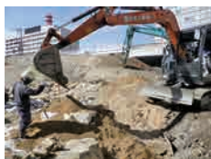
灯標基礎養生埋め戻し
