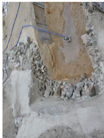
第3期南側防波堤 南面石垣裏込め検出状況 (東から)
