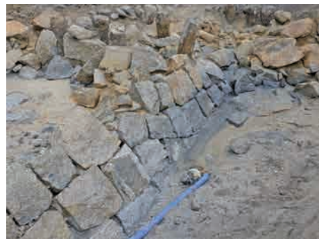
fig59 南西部北面石垣変曲部（北東から）
