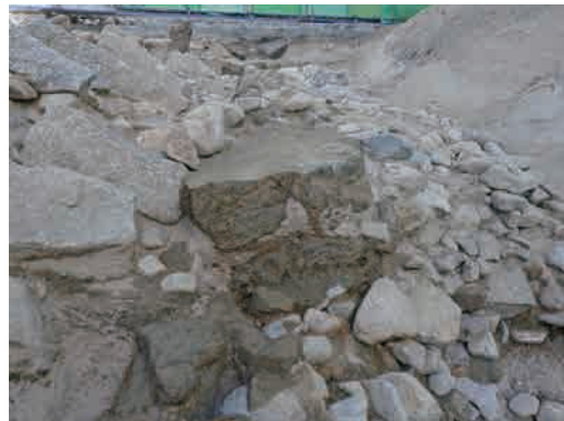
fig21 南側防波堤粘土ブロック積み断面
