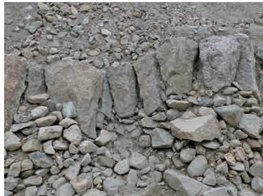
fig13 第4期北側防波堤石垣裏込め（南から）
