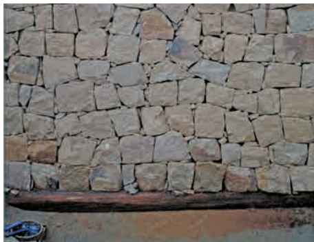
写真2 舞子砲台跡第4次調査 石垣面Q 石垣と土台木
