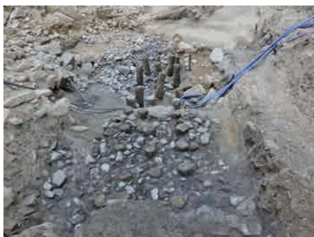
松杭列検出状況（西から）
