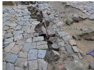
敷石No. 1～18除去後の計測作業風景
