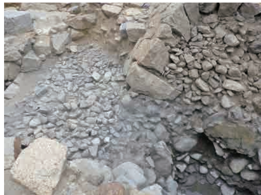
fig17 下層防波堤の落ち込み（東から）
