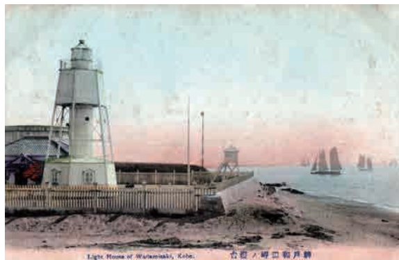
fig8：二代目（鉄造）・旧和田岬灯台 （神戸アーカイブ写真館提供）
