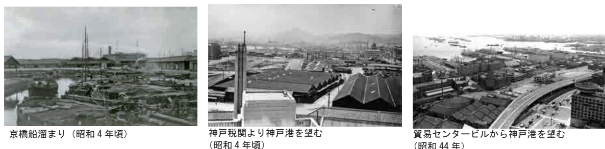
fig 6 京橋船溜まり付近の旧景（神戸アーカイブ写真館提供）
