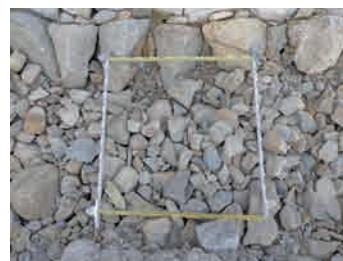
②第3期北側防波堤（西）
