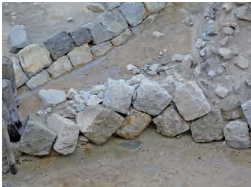
fig22 第3期南側防波堤屈曲部
