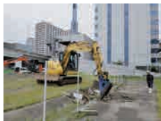
調査開始 コンクリートなど除去
