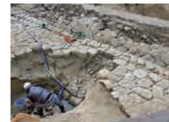
北東部下層石垣を確認
