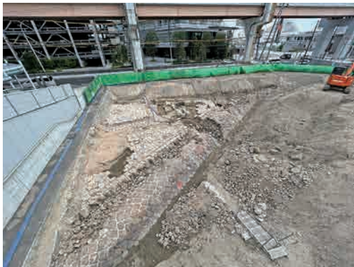
fig12 北側防波堤全景（北東から）
