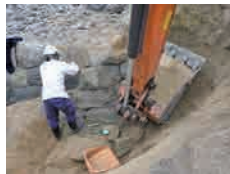
石垣検出作業
