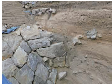
fig55 北東隅部石積み検出状況（南西から）
