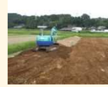
土層改良（客土）
