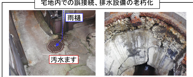
宅地内での誤接続、排水設備の老朽化
