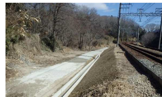
法面保護工事（神戸電鉄）
