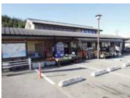
道の駅淡河の現況
