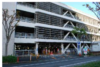
西神中央駅駐車場
