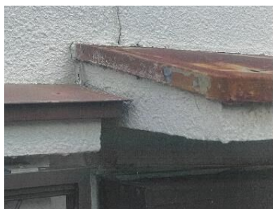
庇材の腐食
