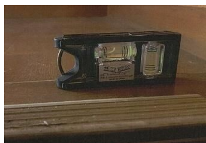
建物の傾き状況を水平器で測定
