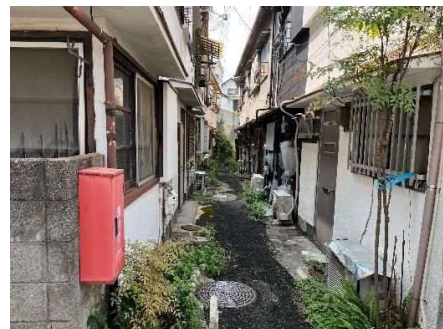
建替困難な土地の状況
