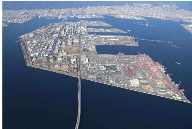
ポートアイランド（第2期）（南側から）
