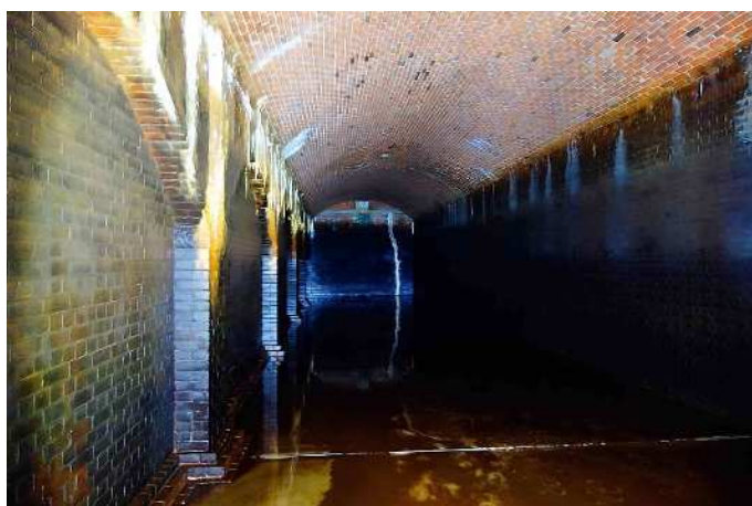
奥平野低層配水池
