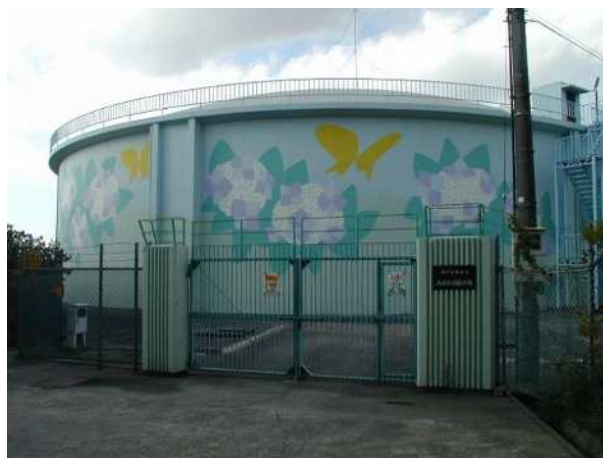
西神低層配水池
