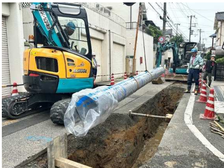
配水管更新工事 （開削）
