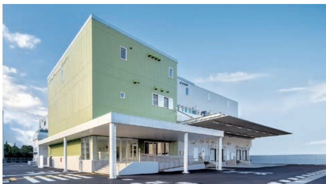
▲神戸市第一学校給食センター（外観）
