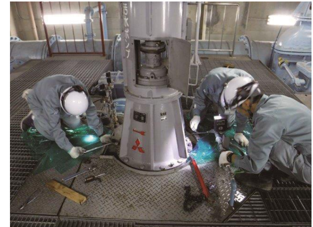
設備の補修・修繕
