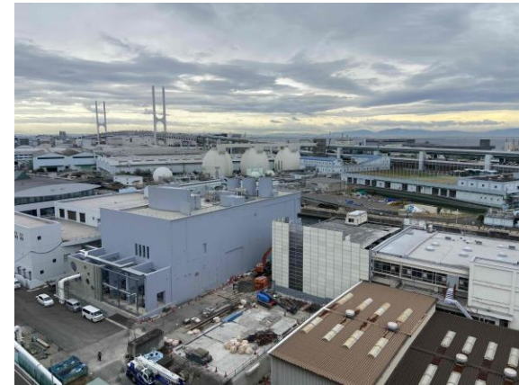
魚崎ポンプ場 改築更新事業
