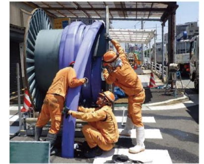
管更生工法による改築更新工事
