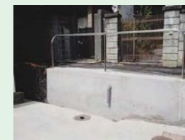
福住通3丁目での手すりの設置
