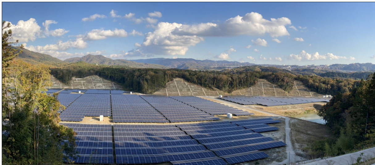
写真 1.10-1 供用後の太陽光発電施設の状況（令和 7 年 11 月 20 日撮影）
