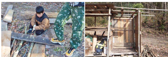
床板にする木材を切断中
