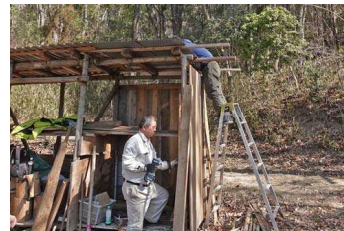
波板の屋根を設置中
