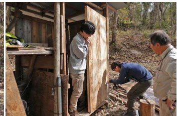
最後に扉を設置
