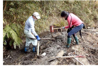
杭の打ち直し
