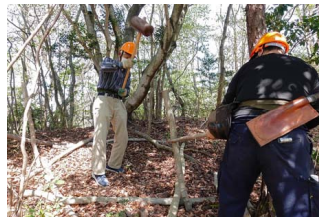
掛矢で杭を打ち込み
