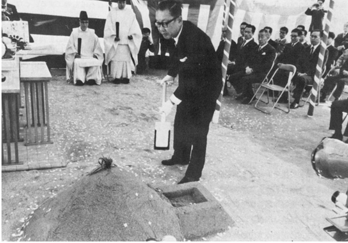
昭和47（1972）年11月25日 挙行された市営地下鉄建設 起工式でクワ入れする宮崎 市長（新長田）
