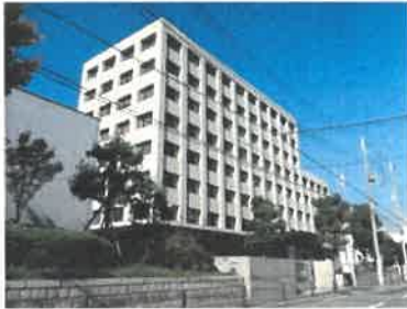
神戸地方検察庁 = 神戸市中 央区橋通1
