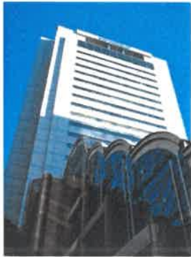
神戸市教育委員会が入るビル＝神戸市中央区東川崎町1
