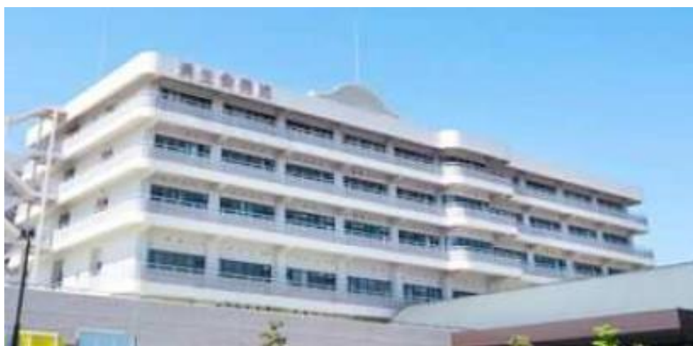
図 2-1 済生会兵庫県病院の外観
