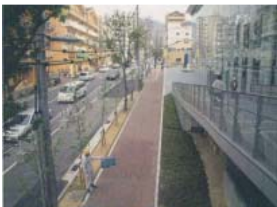
着手前のインターロッキング舗装
