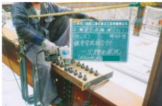
高力ボルト締付け作業
