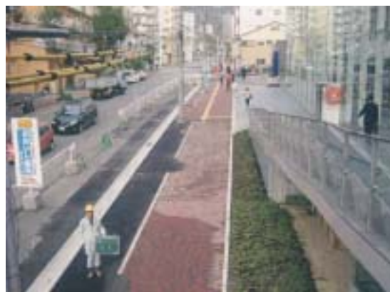
完成時のインターロッキング舗装
