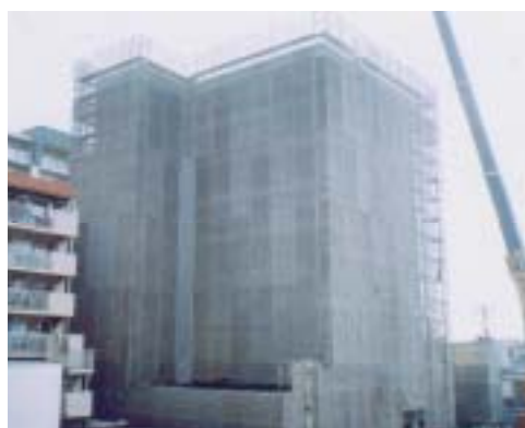
足場及び養生シートの設置状況
