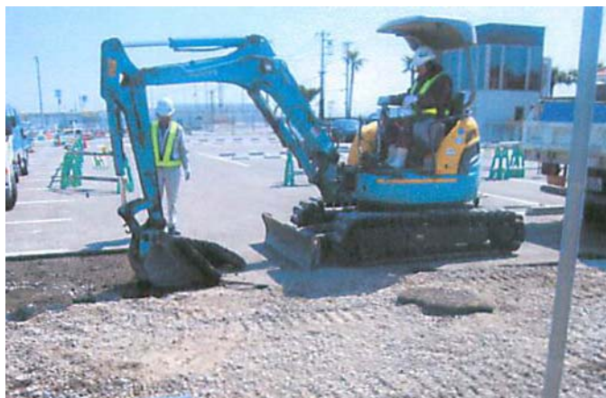
機械施工の状況
