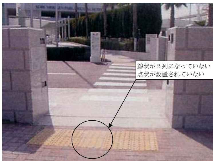
本工事の設置状況
