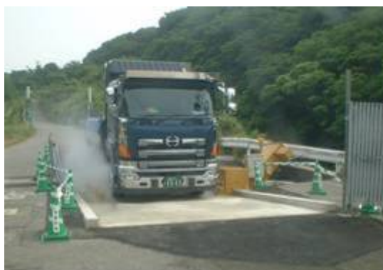
ダンプカー用泥落装置（湿式）
