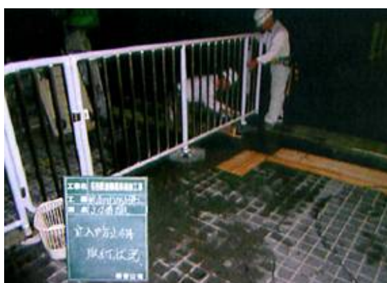
軌道内立入禁止柵設置工
