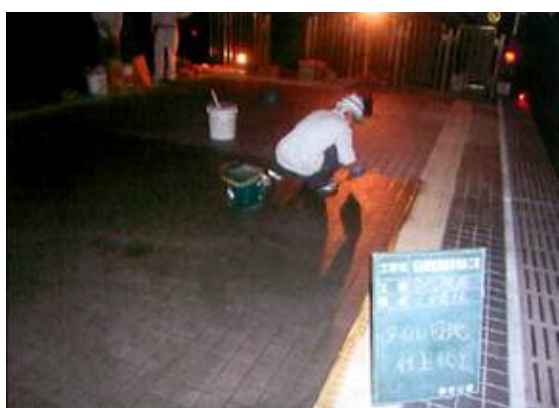
プラットホーム復旧工
