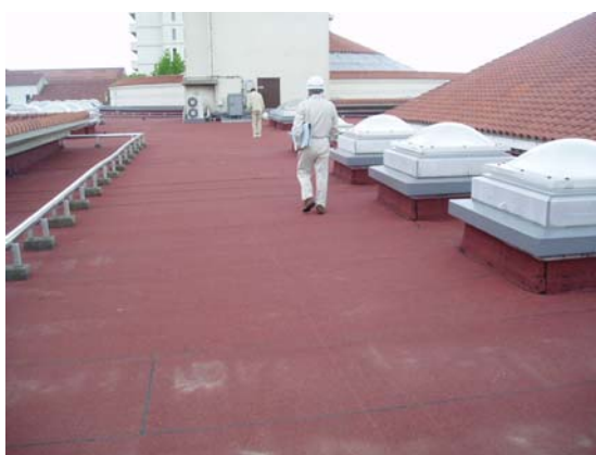
温泉健康センター屋上
