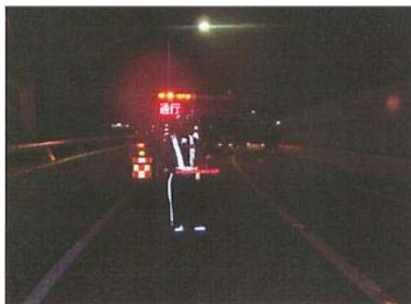
点検業務状況（夜間道路規制中）
