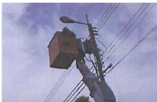
高所作業による球換え作業中
