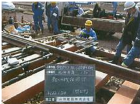
転てつ機据付
