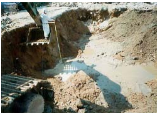
パワー・ショベルのバケットに乗って作業している状況
