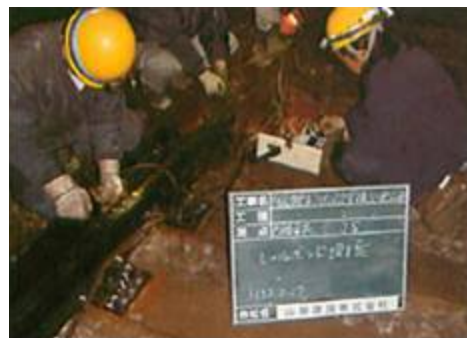
レールボンド線復旧
