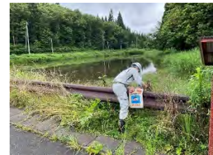
注意喚起看板の設置状況
