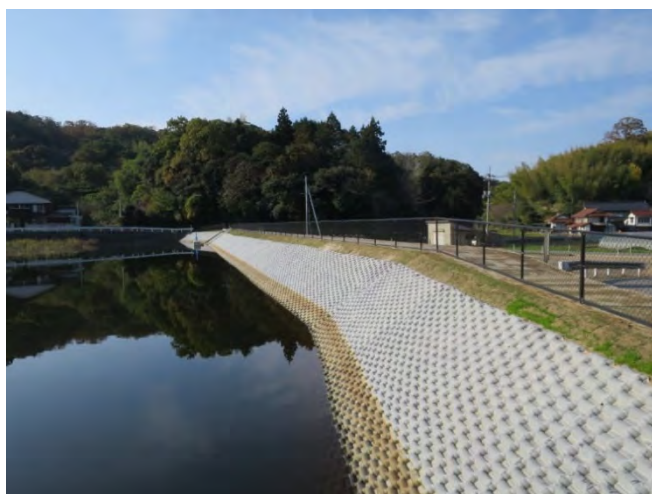
上流斜面波除護岸（防災ステップ布製型枠）
