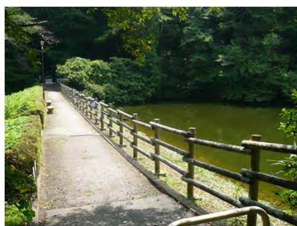
転落防止柵の設置状況
