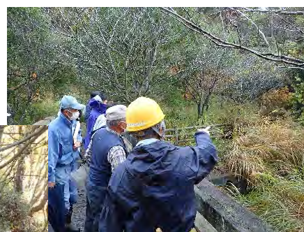
安全対策（転落防止柵の設置状況）の確認
