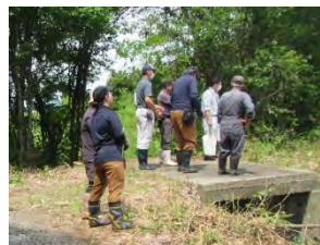
緊急点検の実施状況
