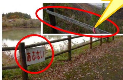
応急対策の状況
