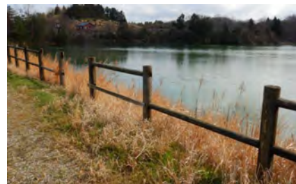
安全柵の破損状況
