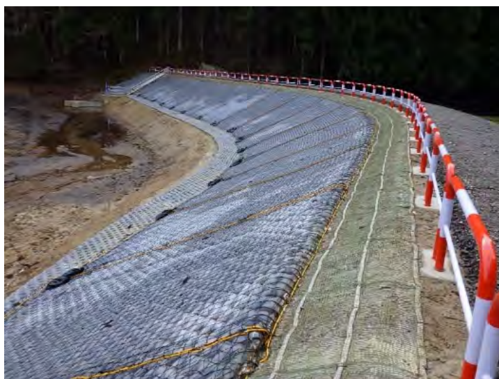
農村地域防災減災事業で設置した安全ネット
