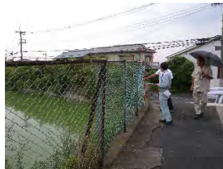
安全柵の点検状況
