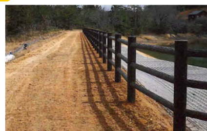
全面更新整備の状況
