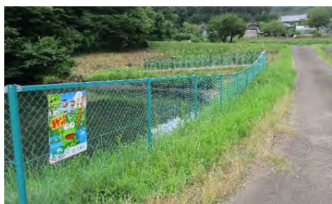
ネットフェンスの設置状況
