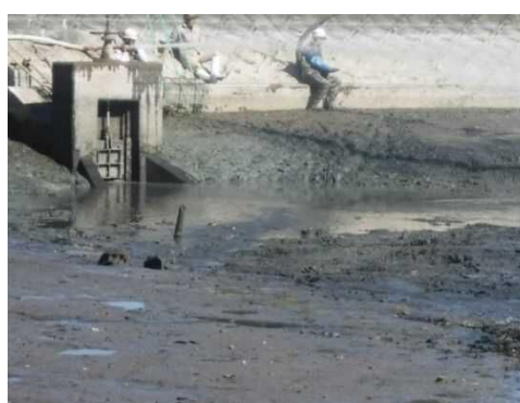
泥土除去後の状況(かいぼり実施後)
