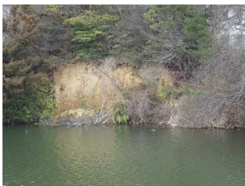
ため池周囲 土砂崩壊
