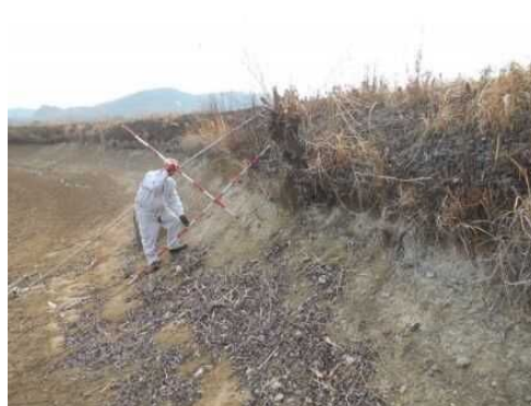
堤体の浸食状況等の点検
