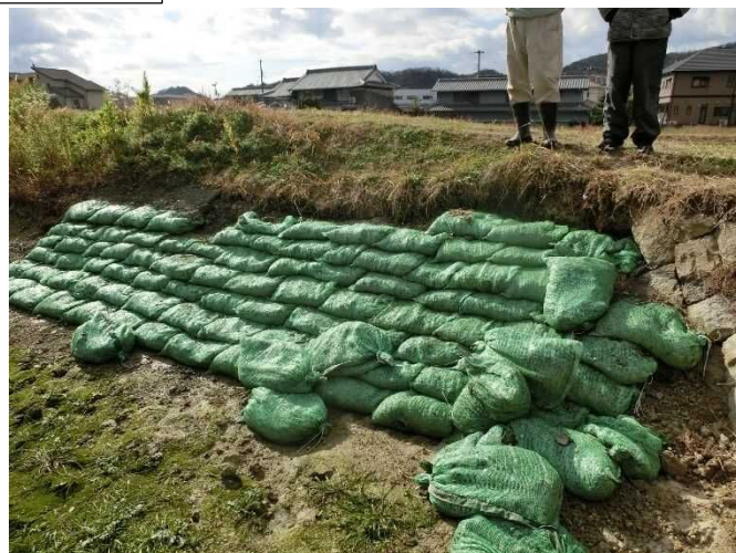
堤体上流法面に土のう設置
