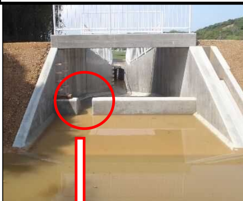
【南あわじ市 洪水吐越流堰の切欠き】
