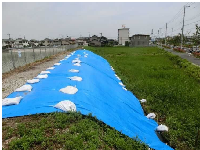
堤体下流法面にブルーシート設置
