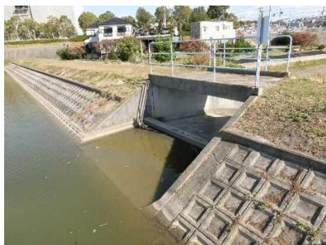
洪水吐(上流側)
