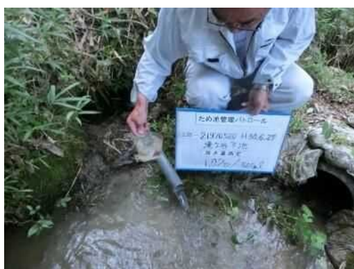
後法 漏水量測定(遠景)
