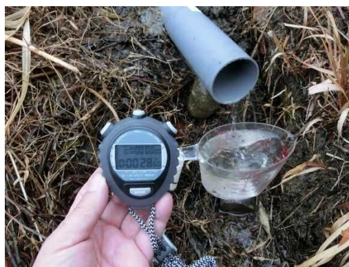
後法 漏水量測定(近景)
