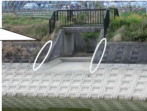
洪水吐(貯水池側より)
