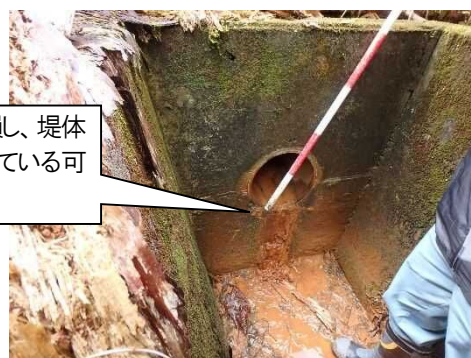
底樋出口(堤体下流)
