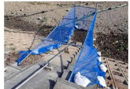
取水施設周りに防風ネットを設置
