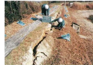
写真-1 堤体亀裂状況
