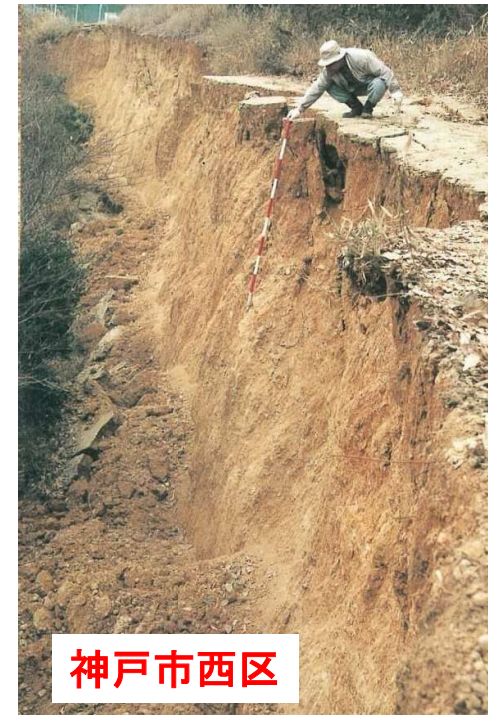
写真-1 堤体亀裂状況
