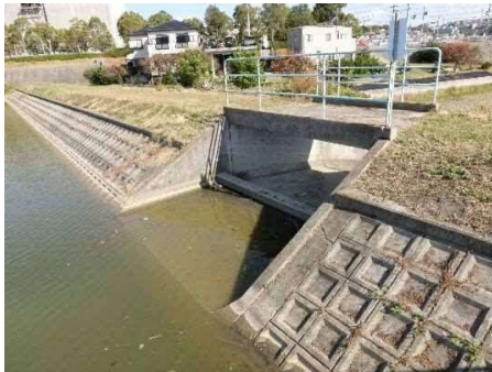
洪水吐(上流側)
