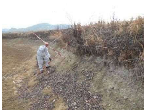
堤体の浸食状況等の点検
