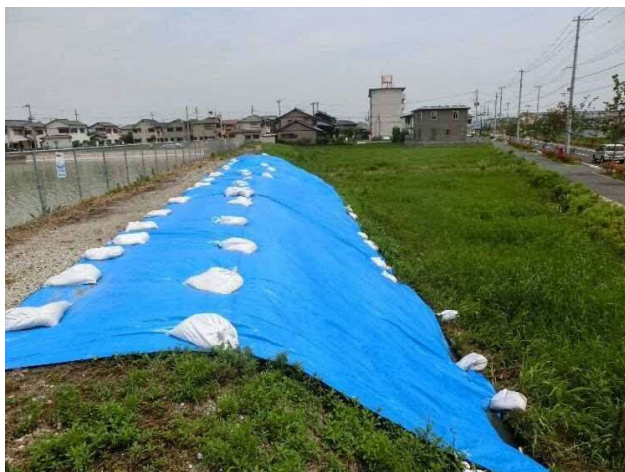
堤体下流法面にブルーシート設置
