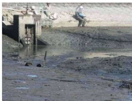
泥土除去後の状況(かいぼり実施後)
