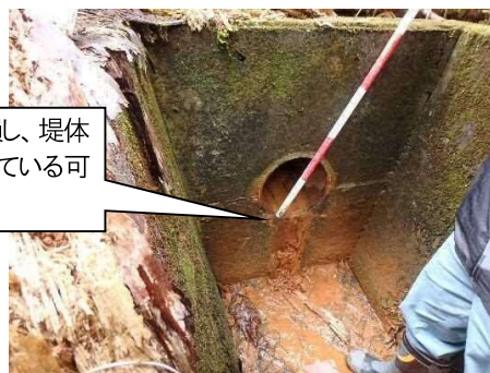
底樋出口(堤体下流)
