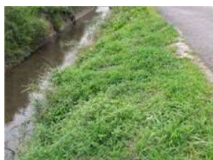
発生エリア全景
