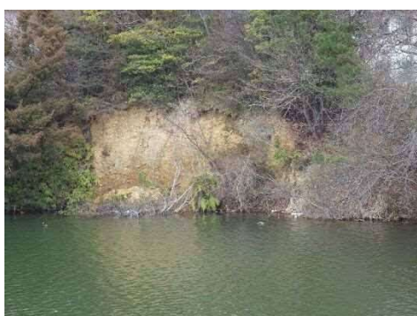
ため池周囲 土砂崩壊
