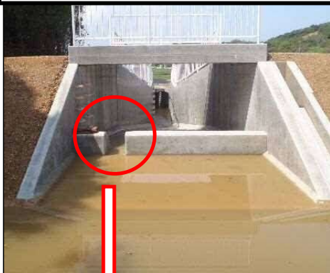
【南あわじ市 洪水吐越流堰の切欠き】
