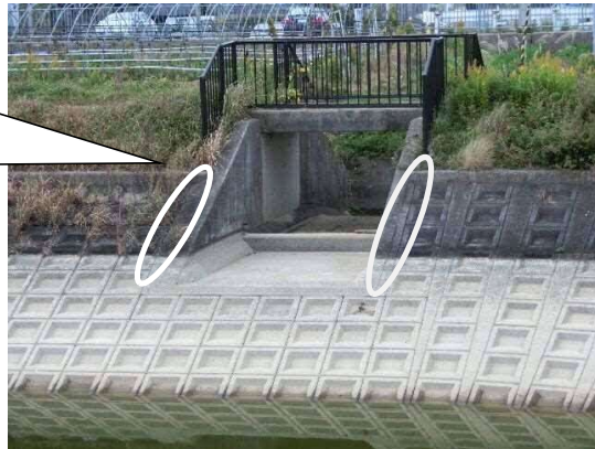
洪水吐(貯水池側より)
