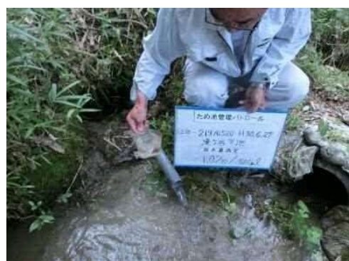
後法 漏水量測定(遠景)
