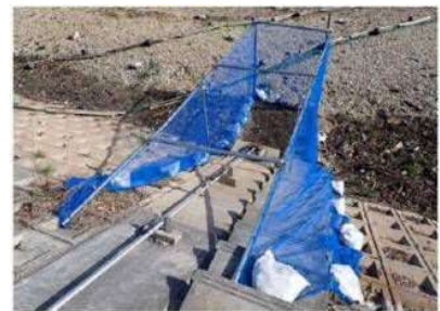
取水施設周りに防風ネットを設置
