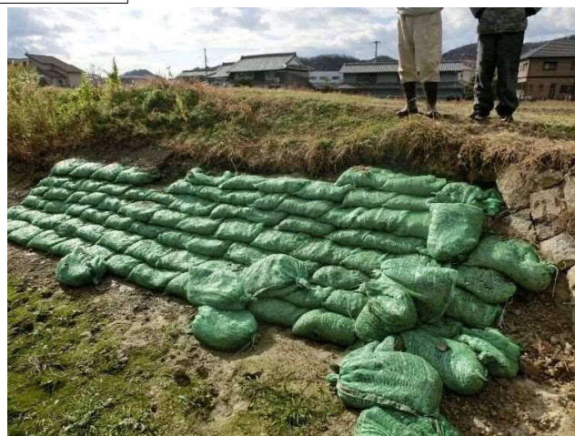
堤体上流法面に土のう設置
