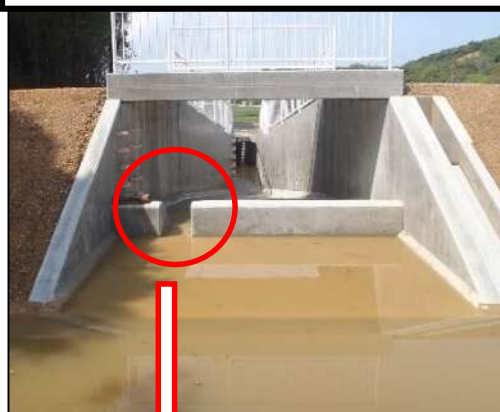
【南あわじ市 洪水吐越流堰の切欠き】
