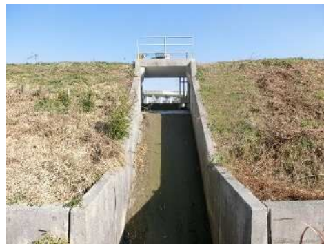
洪水吐(下流側)
