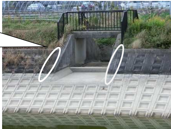
洪水吐(貯水池側より)
