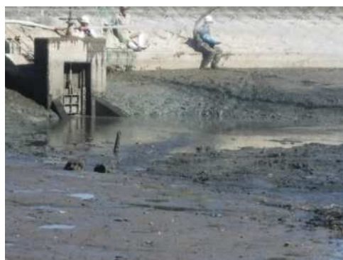
泥土除去後の状況(かいぼり実施後)
