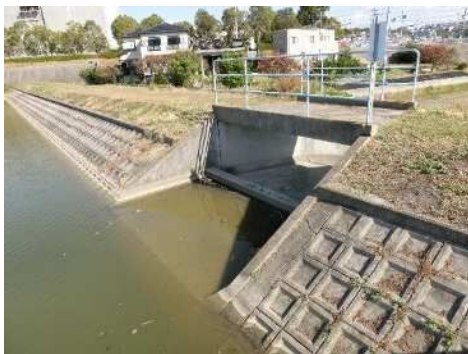
洪水吐(上流側)
