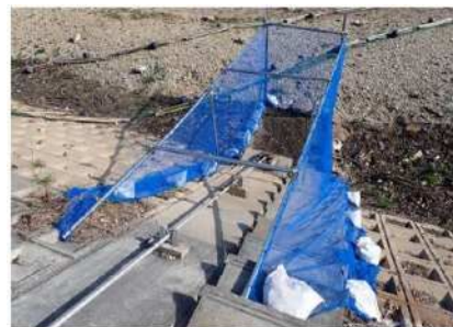
取水施設周りに防風ネットを設置
