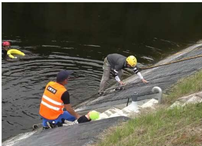
法面にネットの設置
