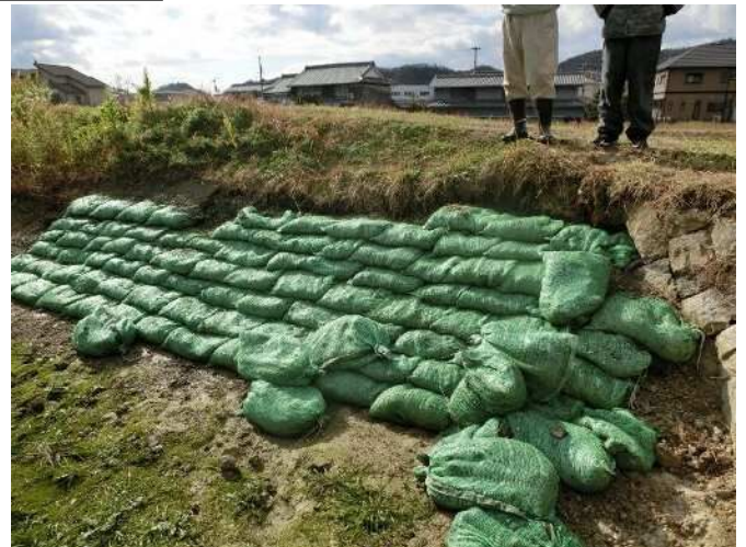
堤体上流法面に土のう設置
