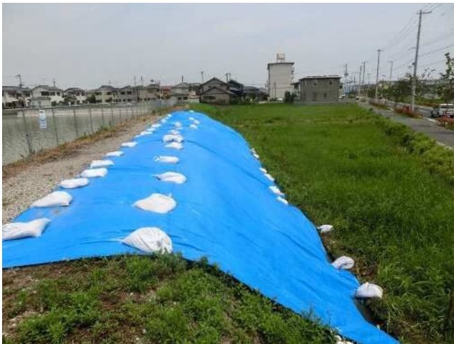
堤体下流法面にブルーシート設置
