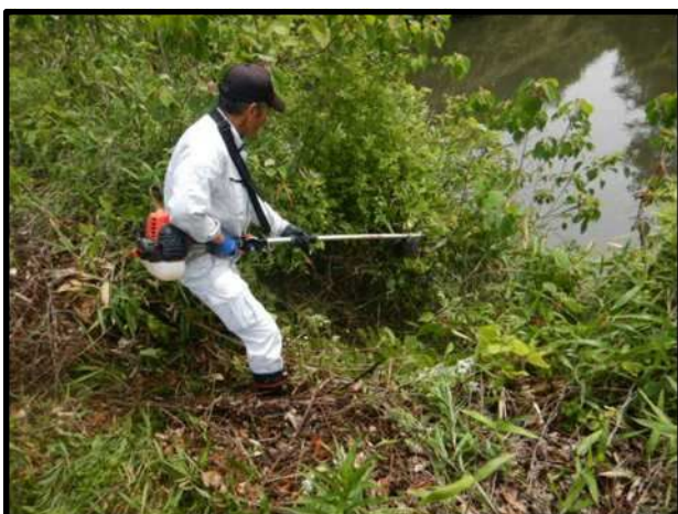
ため池前法での草刈作業の様子
