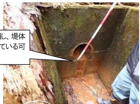
底樋出口(堤体下流)
