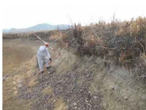
堤体の浸食状況等の点検
