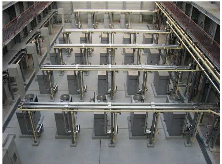
消化ガス発電設備
