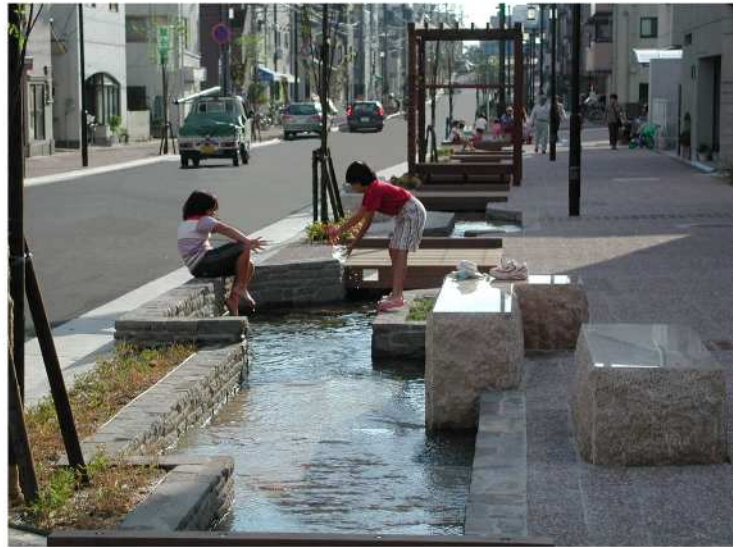
兵庫区松本地区のせせらぎ（鈴蘭台高度処理水を送水）
