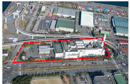
東部スラッジセンター
