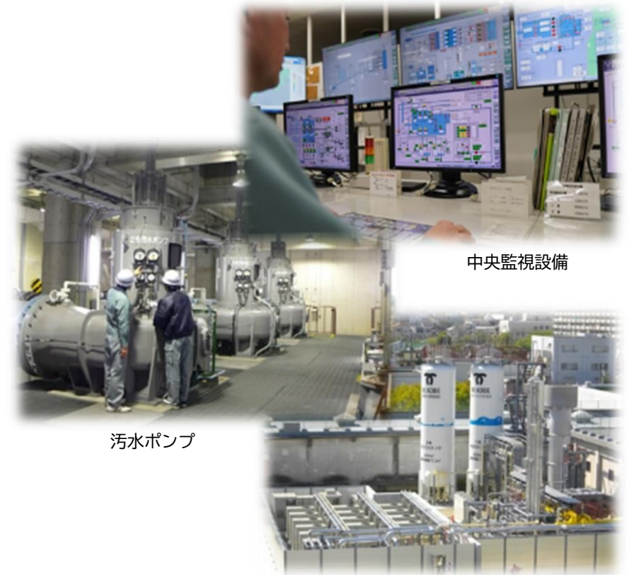
消化ガス精製・発電設備
