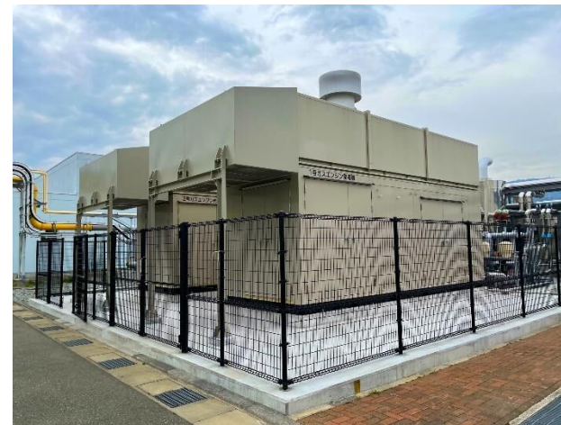
ガスコージェネ設備（発電＋熱の取り出し）
