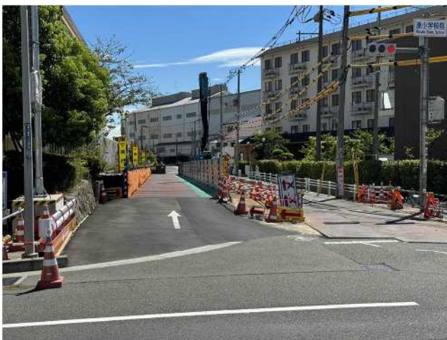
③放流きょ（一部区間では、放流きょ整備のため、既設の蟹川雨水幹線に覆工板をかけて車線切り替えを行っています。）
