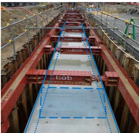
③放流きょ（一部区間では、放流きょ整備のため、既設の蟹川雨水幹線に覆工板をかけて車線切り替えを行っています。）
