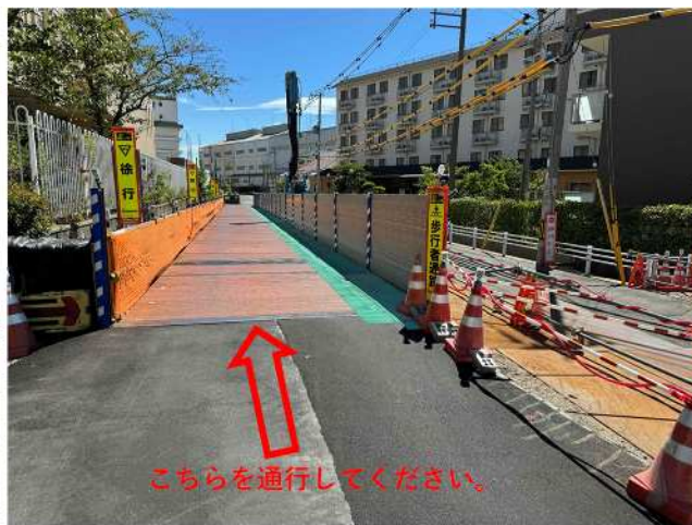
③放流きょ（一部区間では、放流きょ整備のため、既設の蟹川雨水幹線に覆工板をかけて車線切り替えを行っています。）
