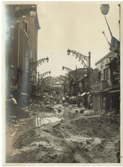
図 28 「減水後の元町通 6 丁目」
