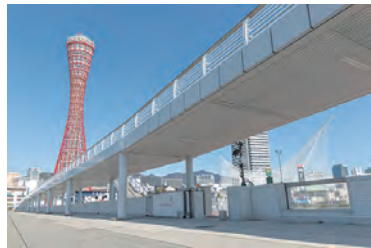
津波対策・防潮堤
