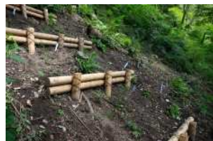
土留めの設置状況
