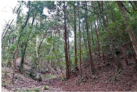
砂防堰堤の下部
