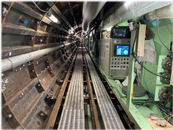
【シールドトンネル】
