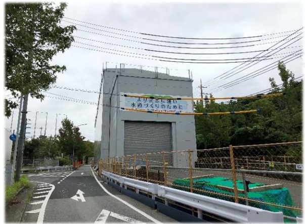
【シールドマシン発進基地】
