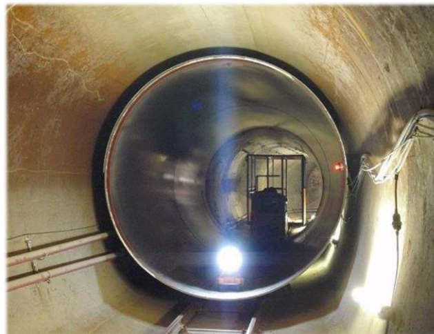
【更生工事の事例 (鋼管挿入)】
