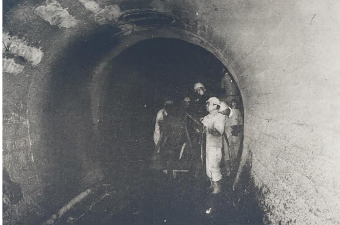
第4回拡張工事の様子
