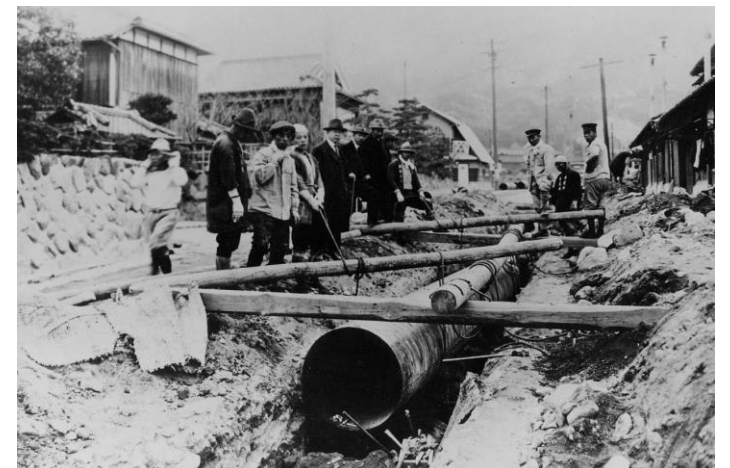
送水管布設工事
