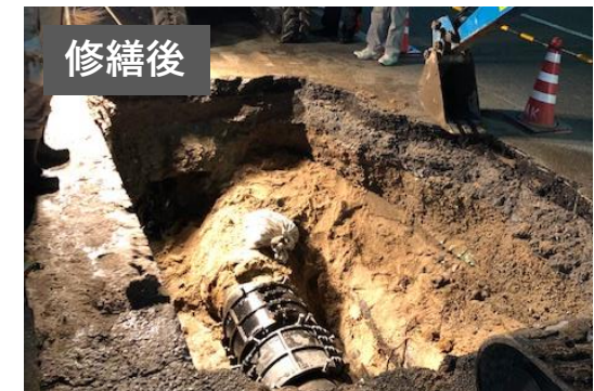
※ 配水管φ500管下に亀裂
