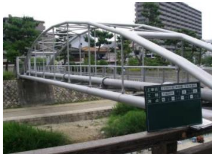
直営作業による点検例 (目視点検)
