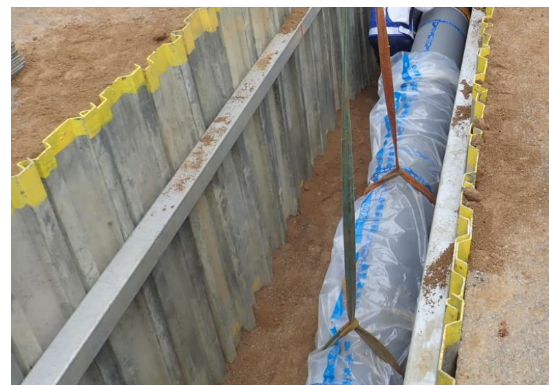
防食被覆の状況 (ポリエチレンスリーブ)
