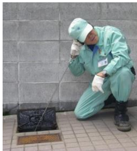
漏水調査例 (音聴棒)
