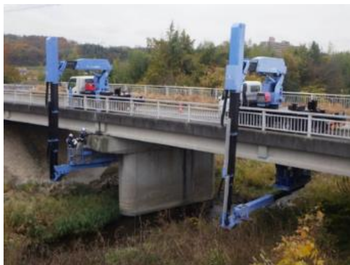
道路橋梁の法定点検例 (橋梁点検車を用いた近接目視点検)
