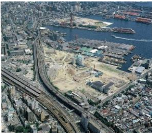
建設初期のハーバーランド。学校（敷地右下）から建設が始まった。 画像：『KOBE HARBORLAND』より
