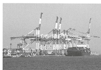
六甲アイランドRC-6/7に22列対応 高規格ガントリークレーン3基設置
