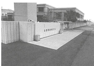
59.8kmの防潮堤及び鉄扉等の完成
