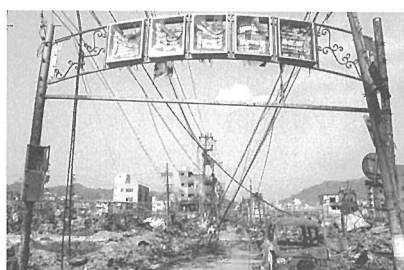
被災した市内の様子
