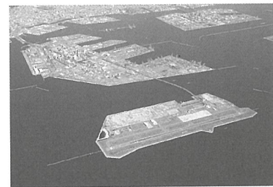
神戸空港島竣工
