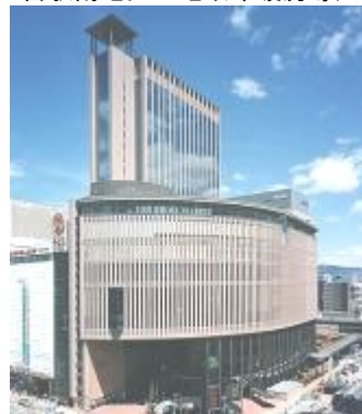
■三宮駅南地区の地域冷暖房導入施設
