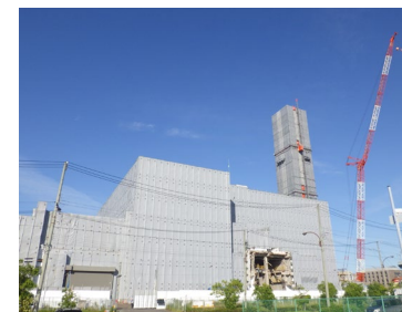
解体中の旧港島クリーンセンター
