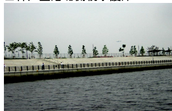
■神戸空港北側親水護岸
