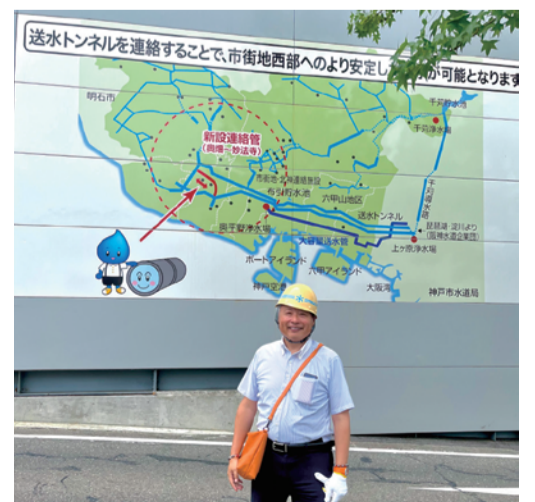
神戸市須磨区：送水トンネル工事の視察
