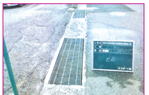
㉔ 溝蓋の異音防止改修
