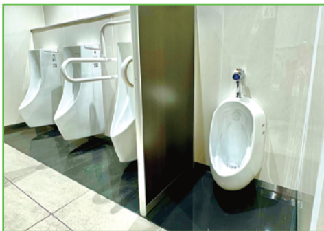
⑯-② トイレ改修後
